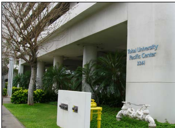
写真1 ホノルル地区にあったHTIC (photo by Kitahama)
